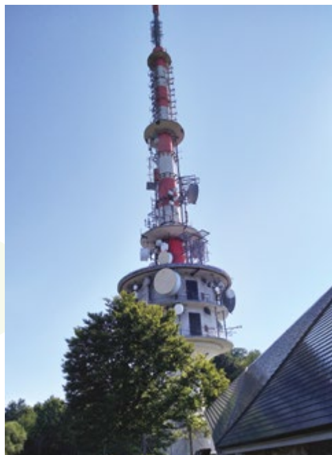
Telekomunikacijski stolp na Trdinovem vrhu
